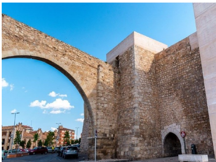
Puerta de San Miguel, conexión con las murallas de la ciudad y el acueducto de los arcos en Teruel
