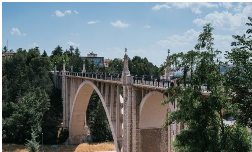
Viaducto de Fernando Hué
